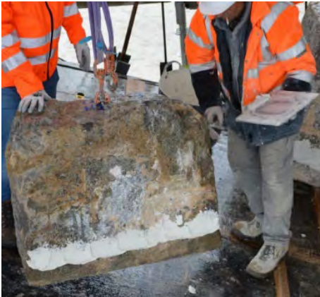
Holivela de izado de dovelas y banda inferior de mortero en la reconstrucción de bóvedas
