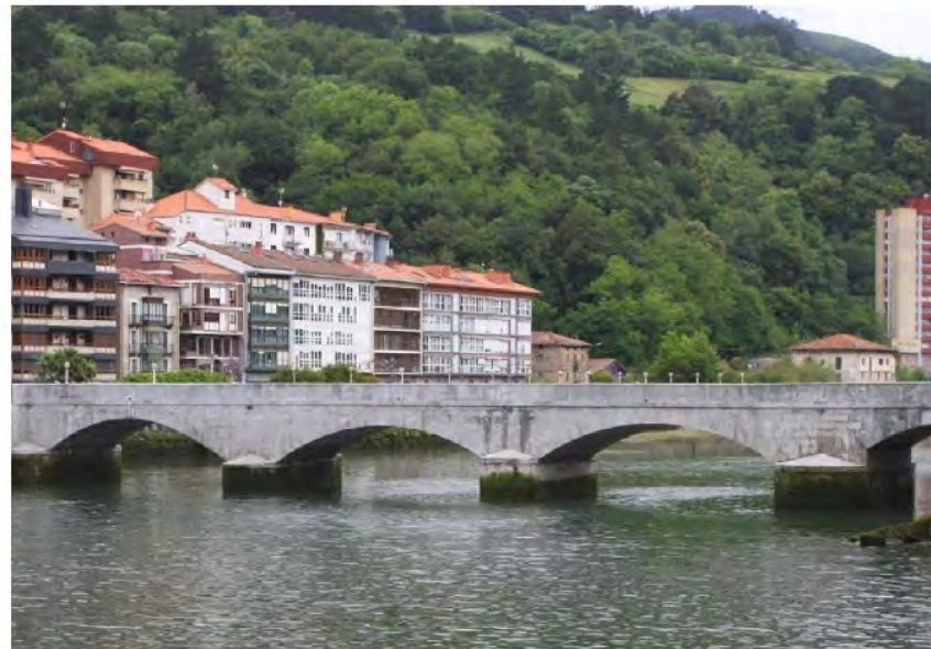
Vista general del puente de piedra sobre la ria, rehabilitado tras el desplome parcial que sufrió en 2018. J.LEON
