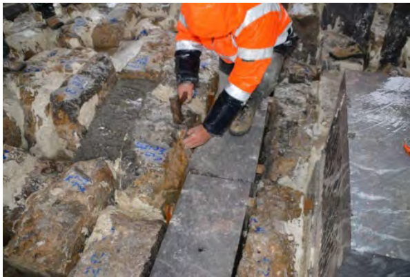
Clavado de cuñas previo al descimbrado
