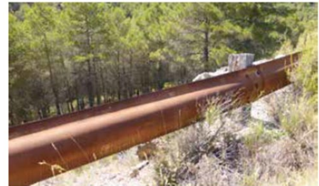
Barrera metálica de una sola onda. Puerto del Ragudo (Castellón). Antigua carretera N-234.
